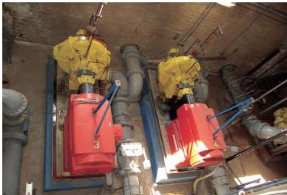
Estas dos turbinas instaladas en los días cuando Lawrence abastecía de agua a la ciudad de Methuen están previstas a ser reemplazadas por 2 de menor capacidad, aunque más eficientes y lo suficientemente fuertes como para suministrar agua a Methuen y Andover en caso de emergencia sin sacrificar a Lawrence, nos explicó John Isensee, el director interino de LDPW. El consumo promedio de agua de Lawrence es de 6.5 millones de galones al día.
