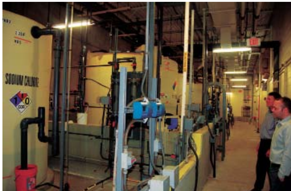
Diferentes químicas son añadidas al agua, todas controladas por computadora. Observando están John Isensee, LDPW director interino y Brian Peña, Ingeniero de Woodard & Curran.
